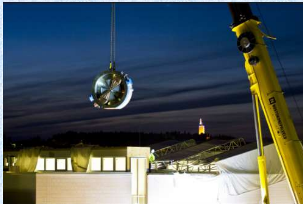
2009 г. Ювяскюля, Финляндия. Монтаж циклотрона МСС-30/15
